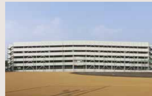
（蔵本）立体駐車場新営（平成25年10月完成）
