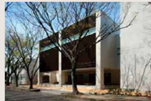
（南常三島）地域連携プラザ新営（けやきホール）（平成26年2月完成）
