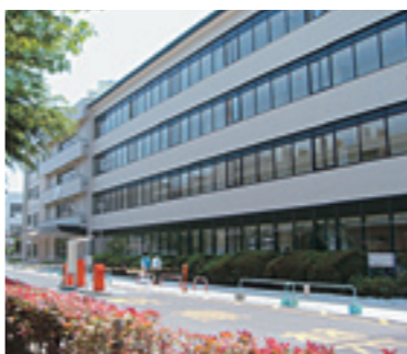
総合教育研究棟（B館）改修 平成20年3月竣工
