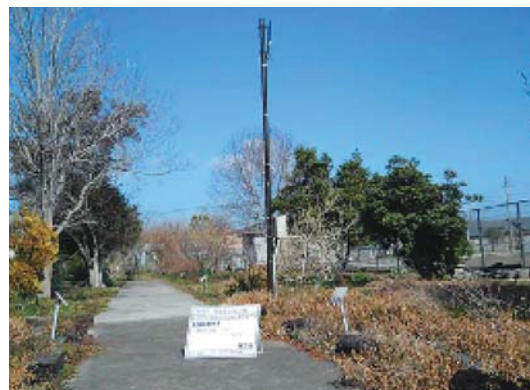
アンテナと AP (敷地南側)
